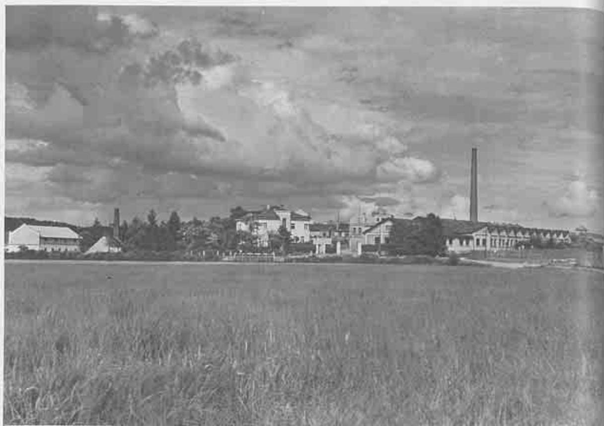
CELKOVÝ POHLED NA POBOČNÝ ZÁVOD — 1940
