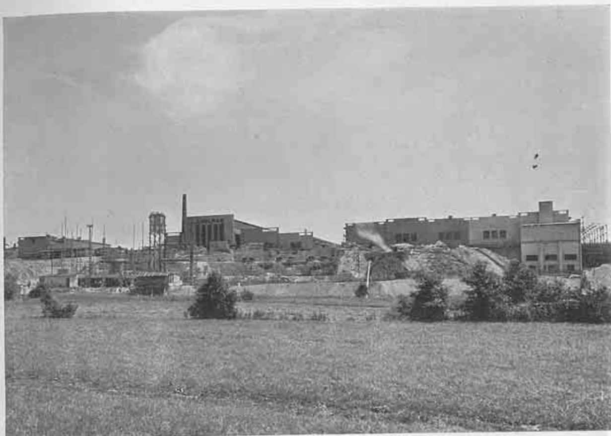
STAVBA NA ZADNÍM TRAKTU TOVÁRNY
