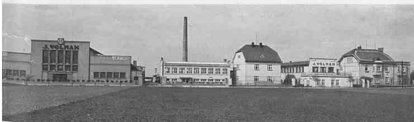
CELKOVÝ POHLED NA TOVÁRNU V ČELÁKOVICÍCH V ROCE 1936
