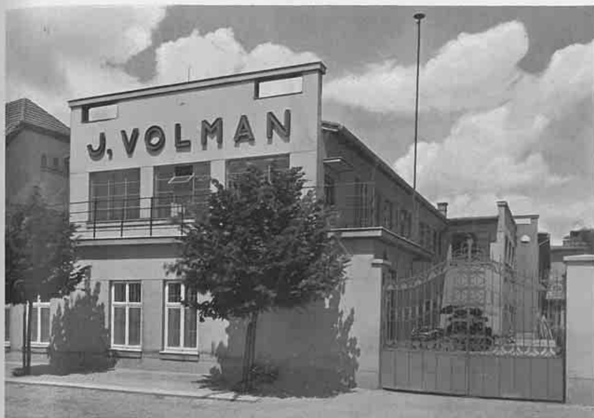
BUDOVA UČŇOVSKÉ ŠKOLY
