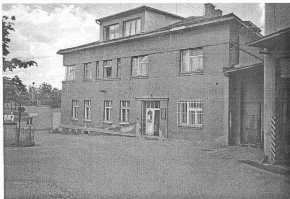
Administrativní budova jaro 2004
